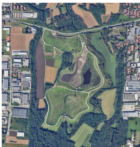
Figura 20 - Foto aerea dell'invaso di laminazione situato a Lomazzo – Bregnano
