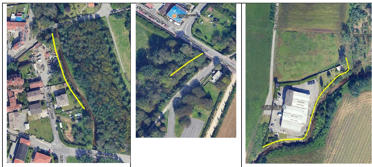
Figura 29 - Muri spondali in corrispondenza dell'area residenziale in via Madonna (a sinistra), Via Marchese Pagani (al centro) e Via Cadorna Luigi (a destra) in Rovello Porro.
